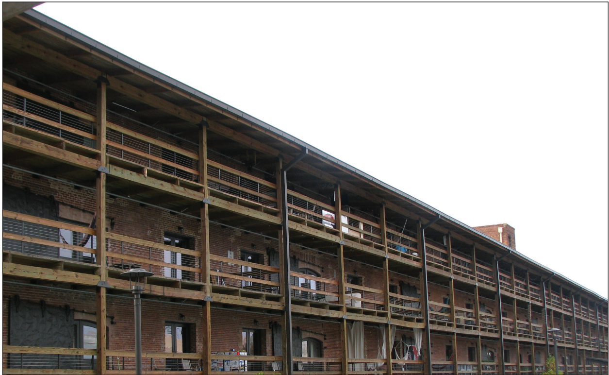
A. East Façade
