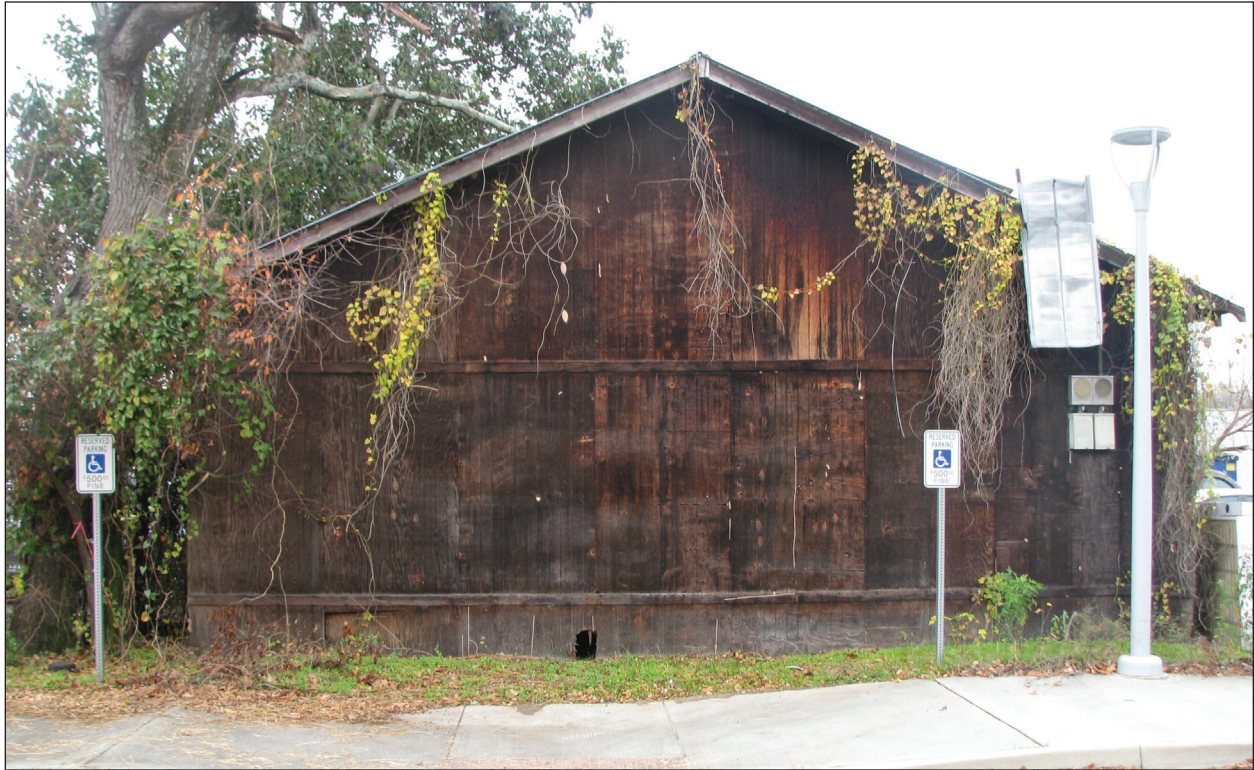
A. East Façade
